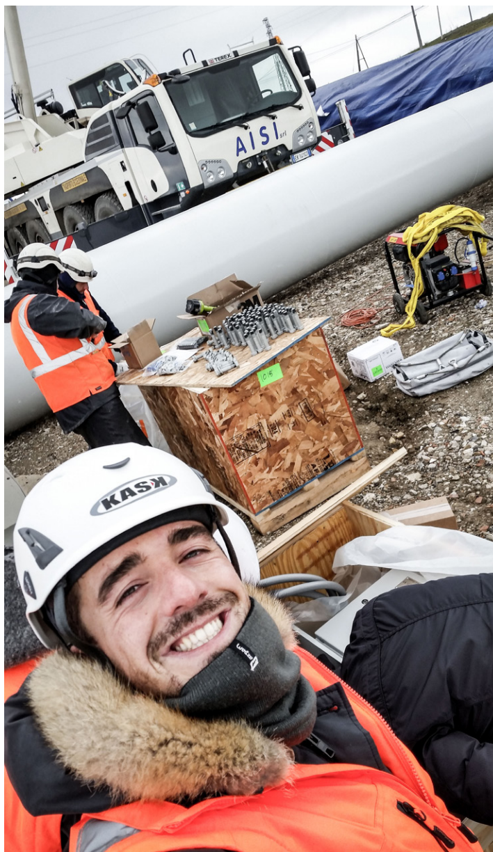
In alto: l'ing. Valentino Capparella, amministratore unico di White Wind Srl e cliente NPS.
