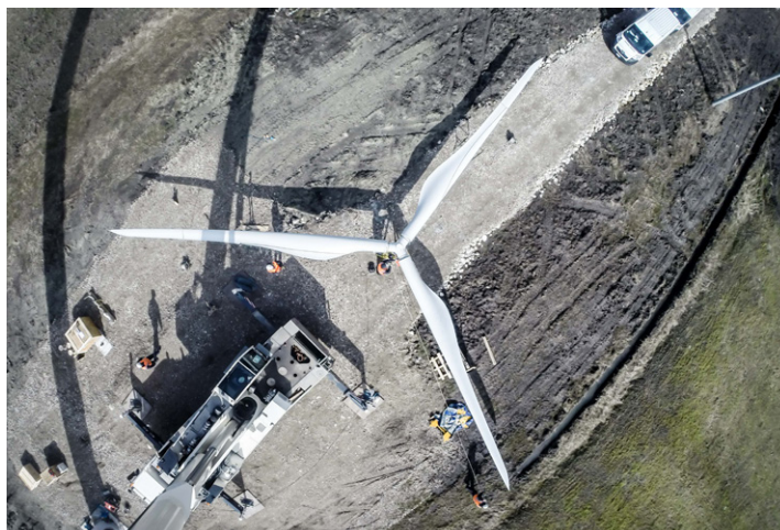
In alto: una fase dell'installazione della Turbina NPS 60-24.
